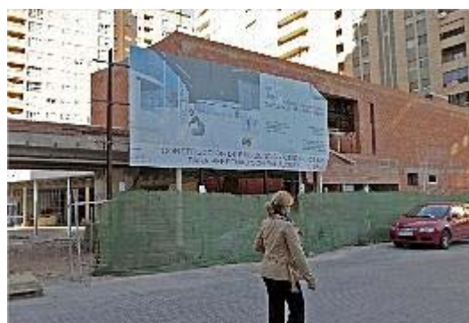
centro de día. El local de Avapace, en José M a Orense, sigue en obras. m. a. montesinos
